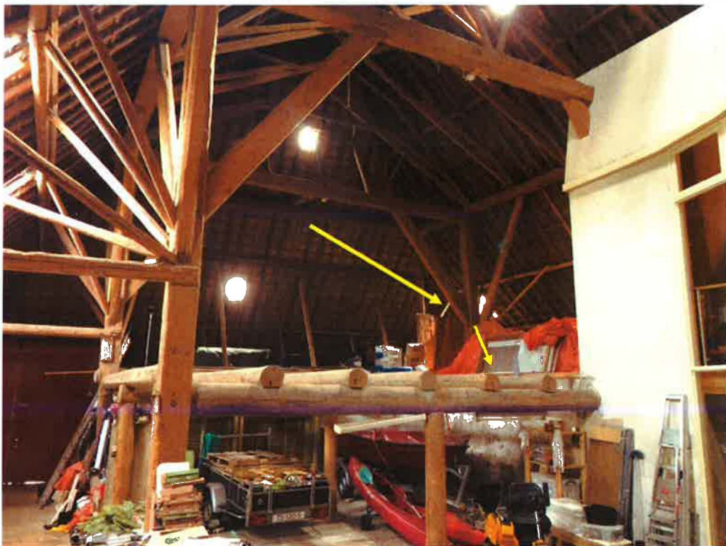
Afbeelding 3.2 – Oostgevel woonboerderij Alddiel 9, binnenzijde. Met de gele pijlen is ter indicatie de transmissie van het muziekgeluid weergegeven naar het plafond van de slaapkamer.
