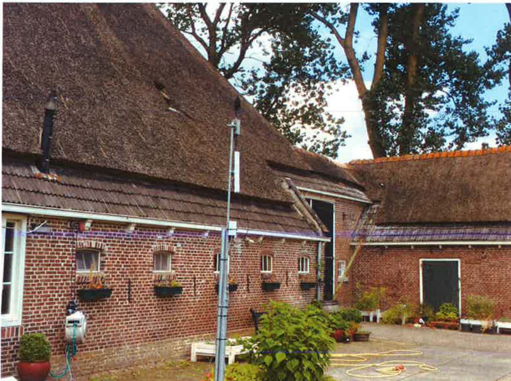
Afbeelding 3.1 – Oostgevel woonboerderij Alldiel 9
